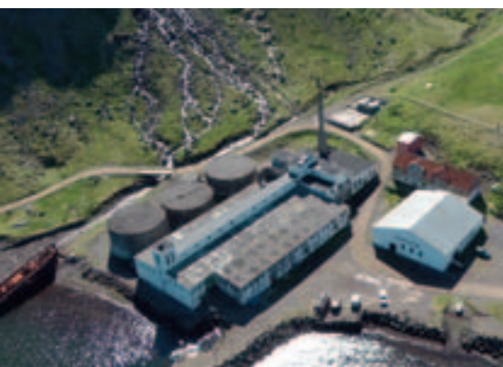
Die Ruine der Fischfabrik in Djupavik bei besten Flugbedingungen
